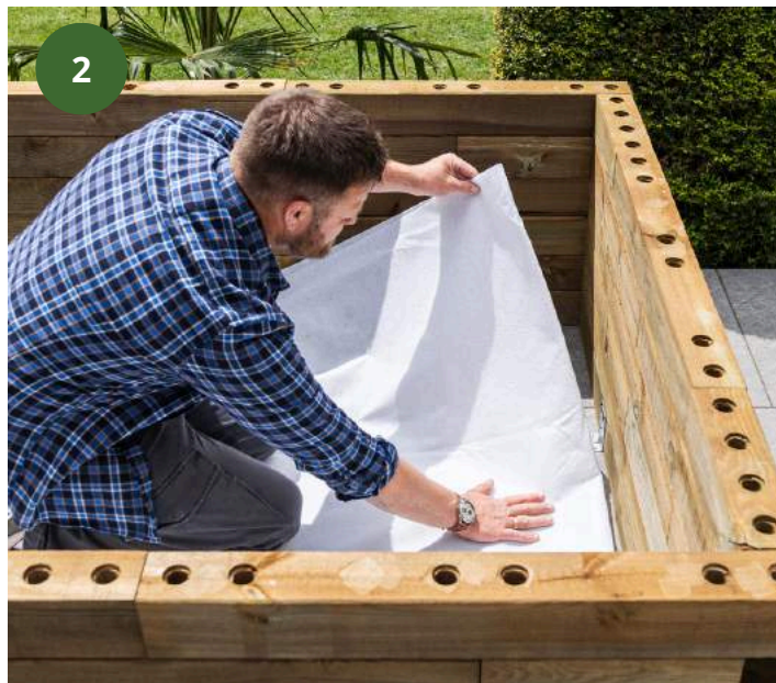
2 Voeg bodembescherming toe - gebruik beschermvlies, oud tapijt of geotextiel doek om ongewenste gaatjes te voorkomen.
