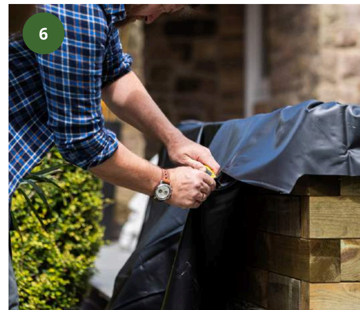
6 Snij wat overtollig materiaal weg - snij voorzichtig iets van de overhangende folie weg (houd voldoende over) om eenvoudiger aanpassingen te maken.
